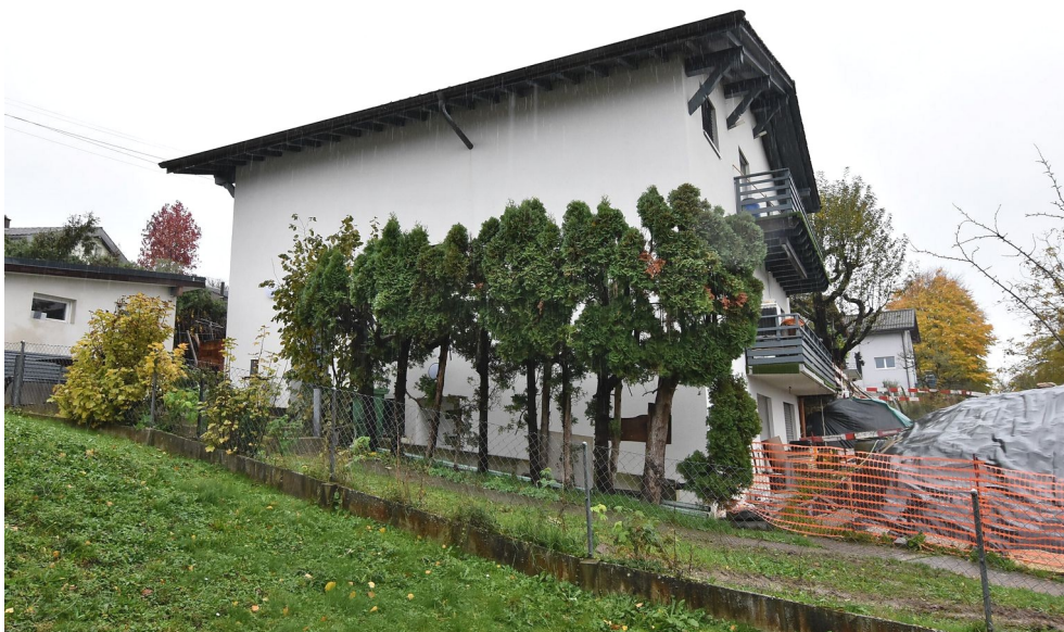
Photo N°3 Façade Nord (entrée)
