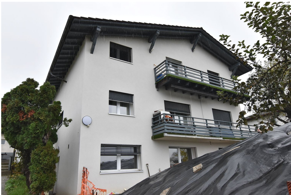
Photo N°2 Façade Ouest (balcons)
