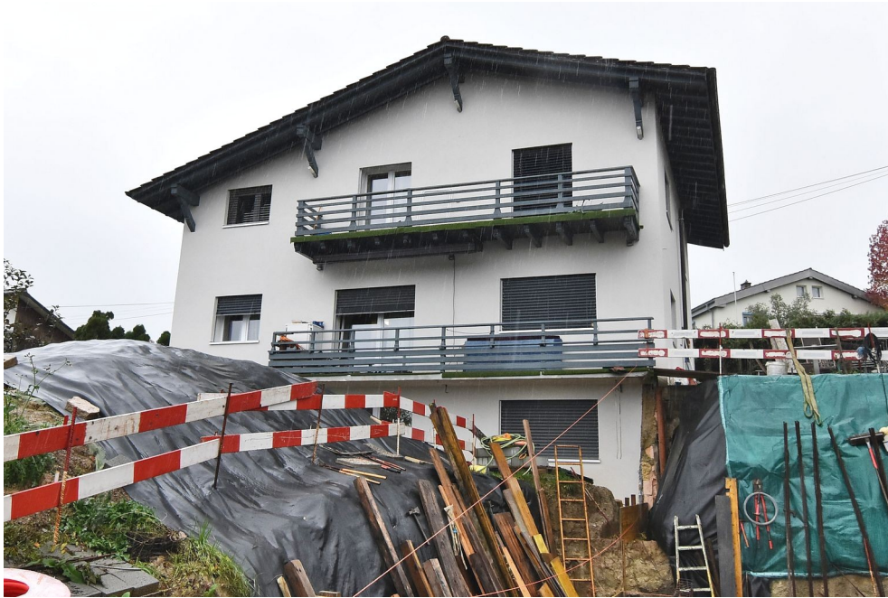
Photo N°1 Façade Ouest (balcons)
