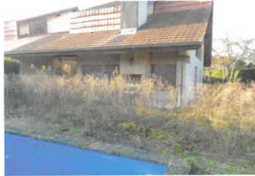
Façade côté Sud
