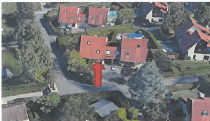
Vue aérienne du lot H2
