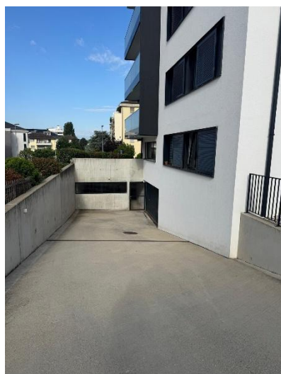
Accès rampe parking
