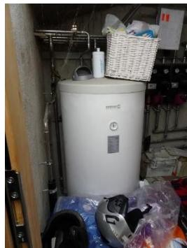
L'eau chaude sanitaire est produite avec la chaudière et le réservoir d'ECS, de marque Brötje, a une contenance de 200 litres.
