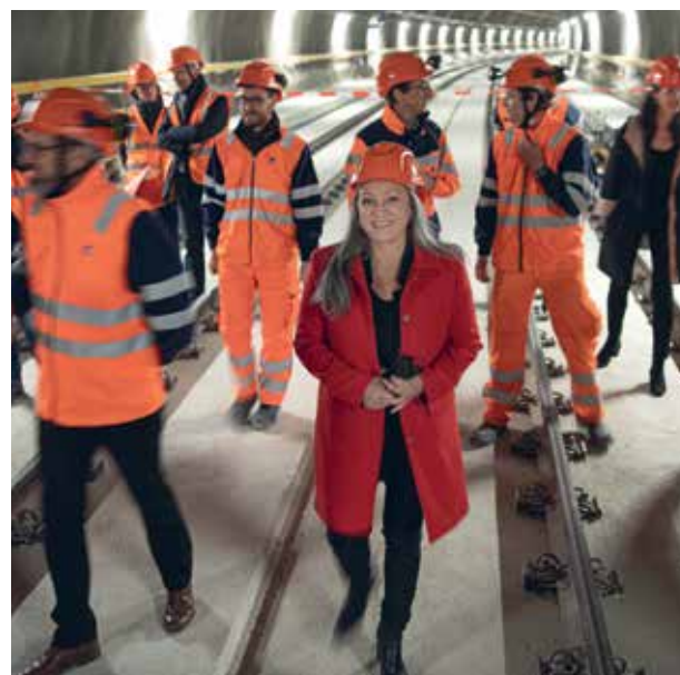
Dans le tunnel du LEB sous l'avenue d'Echallens à Lausanne, lors de la fin des travaux en mars 2022.
