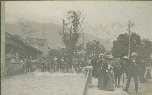
Dégagement des graviers obstruant le pont en béton armé (pont aux Râpes)
