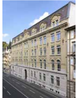
RENOVIERTES GEBÄUDE AN DER RUE DU DR CÉSAR-ROUX 19 IN LAUSANNE, in das die Waadtländer Hochschule für Gesundheit (HESAV) eingezogen ist. © Lionel Henriod
