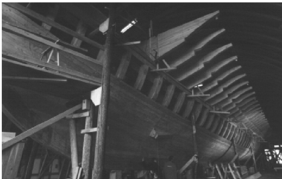
Le chantier naval de La Liberté à Morges, une galère de 55 mètres qui voguera sur le Léman en l'an 2'000: une réalisation de personnes en emploi temporaire subventionné.
