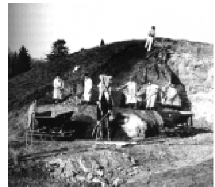
Travaux de terrassement effectués par des aliénés de Cery, inaugurés en 1873
