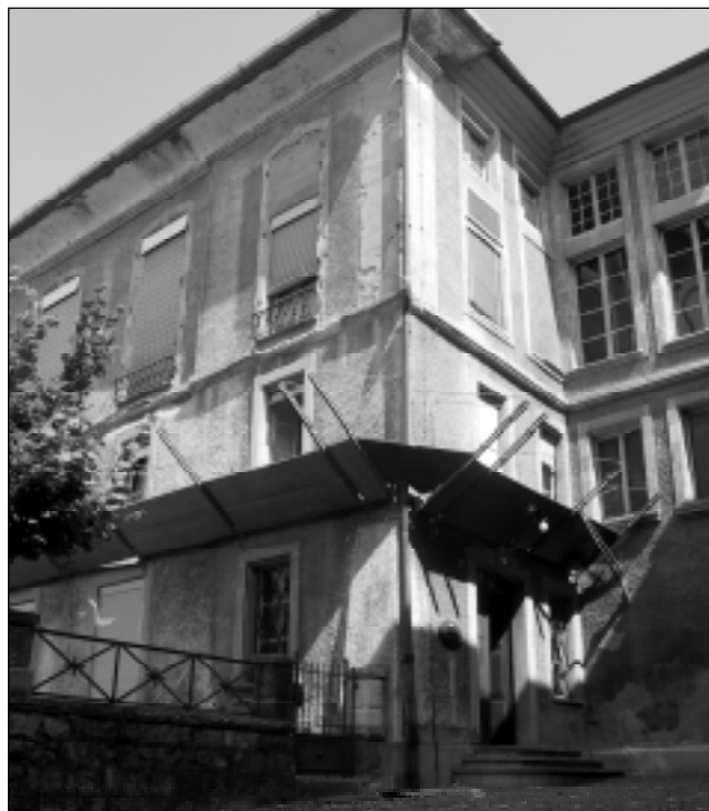
Cité-Devant 11bis ou l'entrée peu glorieuse du Ministère public surplombée par une grossière ceinture de planches chargée de retenir les morceaux de corniche qui dégringolent de la façade.
