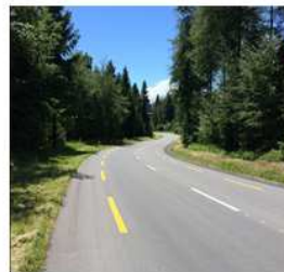
Exemples de chaussée en revêtement bitumineux
