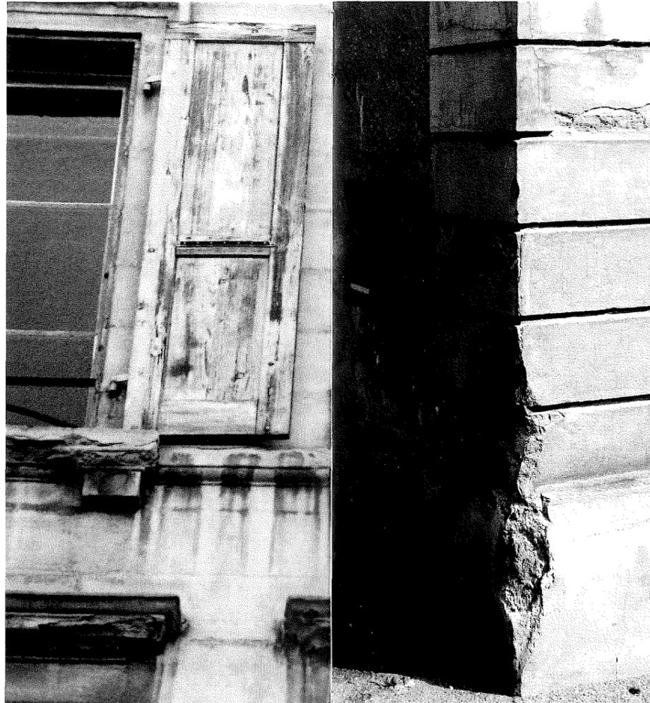
touche discrète de couleur – mieux adaptés aux différentes activités de l'immeuble. Les fenêtres en bois à simple vitrage sont en très mauvais état et mal adaptées aux exigences thermiques; elles sont remplacées par des fenêtres à double vitrage avec des petits bois fins d'aspect proche de celles réalisées à l'époque. Les cadettes en métal ont été entièrement reconstituées à partir du modèle d'origine.
