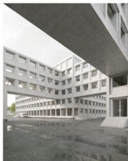
Vue du bâtiment préfabriqué depuis la cour de réinsertion.
