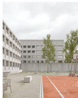
La cour de réinsertion, les bâtiments préfabriqués et la zone de réinsertion.
