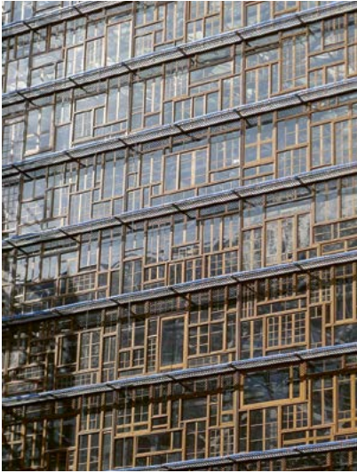
La façade du siège du Conseil de l'Union européenne, à Bruxelles, est composée de plus de 3000 vieux châssis de fenêtres collectés dans les États membres.
