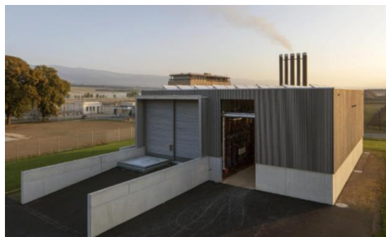
Chaufferie à plaquettes de bois du canton qui a permis une réduction très importante d'émissions de CO 2 .
