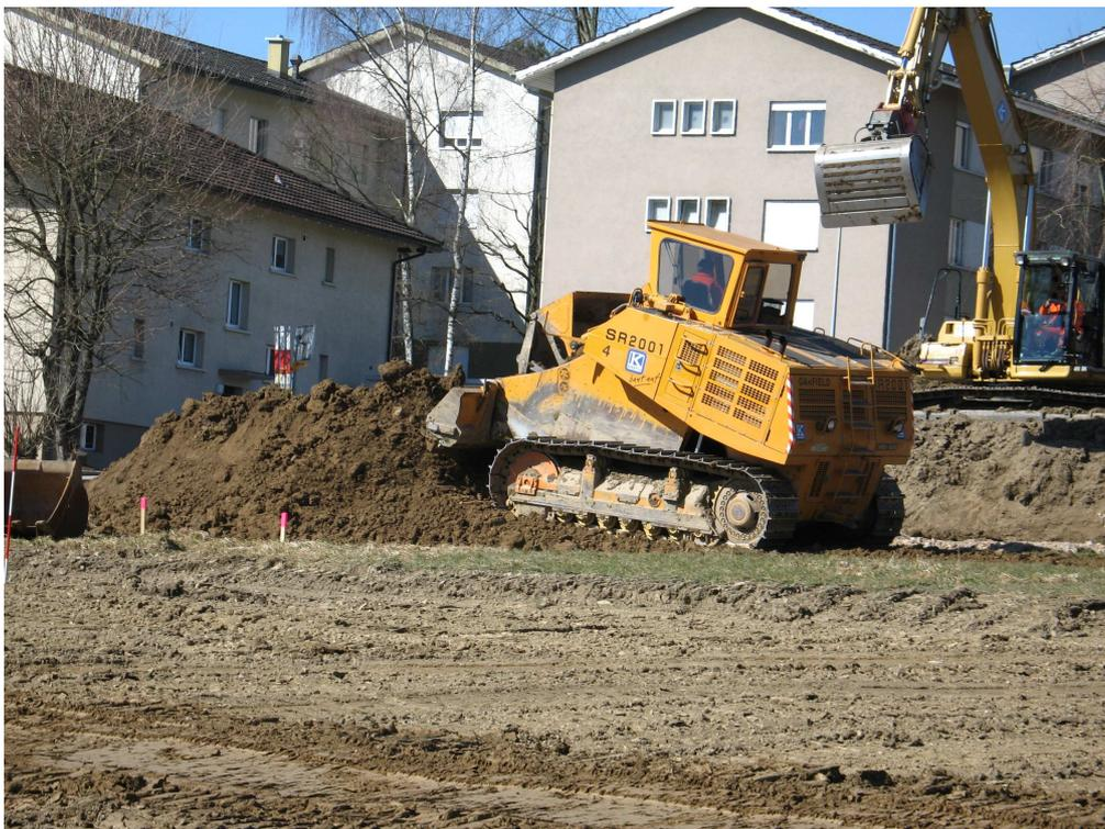
Figure 3. Scraper-dozer en train de constituer un dépôt de terre végétale : La machine doit circuler sur le dépôt, ce qui provoque inévitablement des compactations et une destruction de la porosité. Pour cette raison, ce type de machine ne convient pas pour le décapage de la terre végétale.
