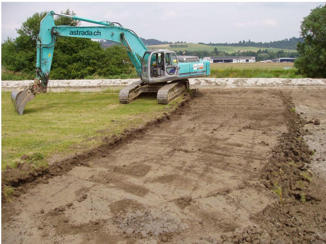
Figure 5 : Décapage en bandes. La machine ne circule pas sur l'horizon B.
