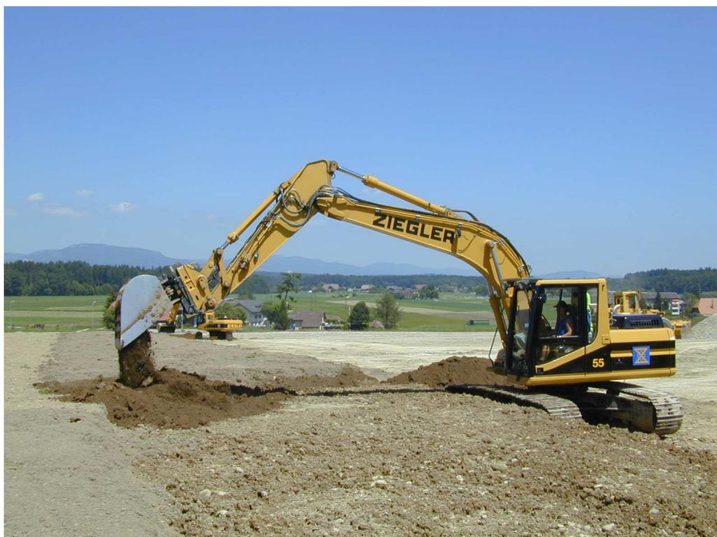
Figure 6 : Reconstitution du sol en depuis l'horizon C. La machine ne circule pas sur le sol reconstitué.
