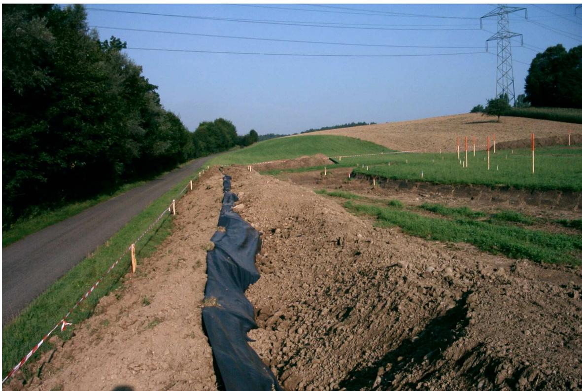
Fig. 9 : Stockage correct des matériaux terreux : à gauche contre la clôture, l'horizon A, puis, séparé par un géotextile noir, l'horizon B. La hauteur des tas est conforme à la protection contre les compactions.
