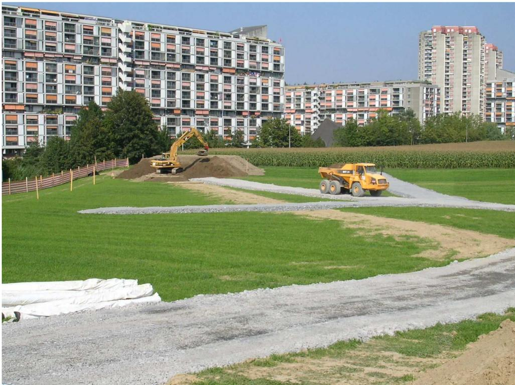
Fig. 8 : Pistes de chantier permettant les transports avec des camions sur la terre végétale.
