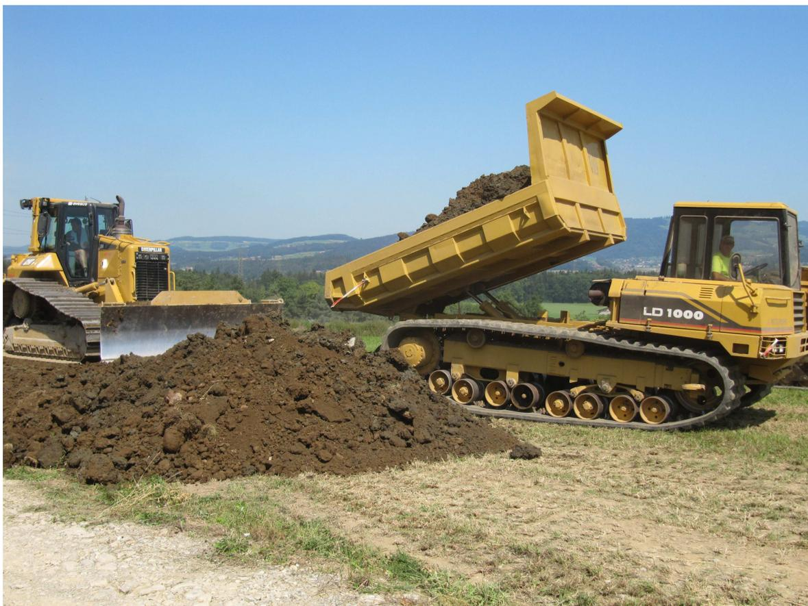
Fig. 7 : Lorsque les dépôts de terre végétale ont plus de dix ans, il est préférable de reconstituer le sol en deux étapes. La première année, l'horizon B est mis en place et est enherbé. L'année suivante, l'horizon A est épandu après avoir fauché l'herbe. Le bull marais est uniquement utilisé pour répartir et aplanir, il ne pousse pas la terre.
