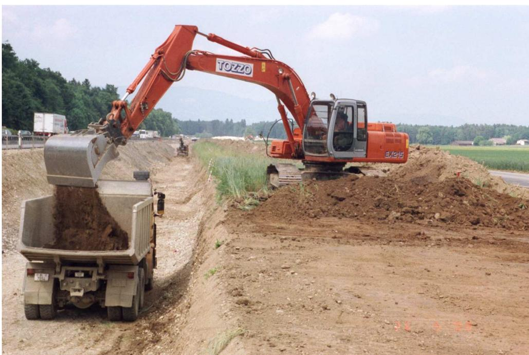
Figure 4 : Décapage depuis l'horizon A. Les camions circulent sur l'horizon C. La pelle ne circule pas sur l'horizon B.
