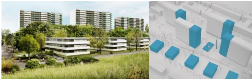
Agrandissement des blocs Sutter & Sutter dans le Lehenmatt
