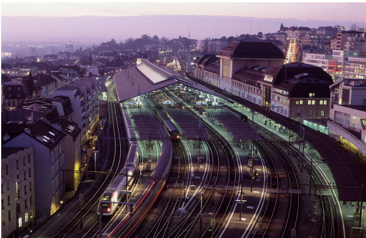
La variante la plus ambitieuse du projet de financement et d'aménagement des infrastructures ferroviaires a été adoptée par le Parlement en juin 2013. D'un montant de 6 milliards de francs, elle inclut notamment la rénovation totale de la gare de Lausanne.
