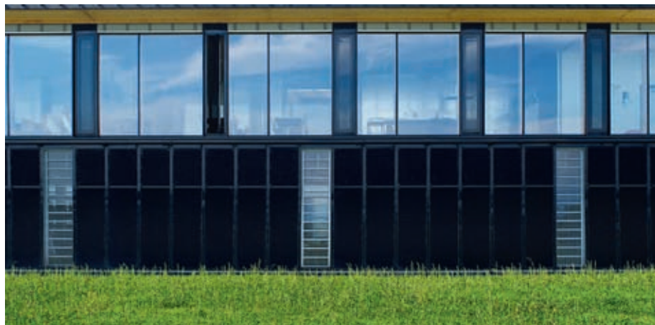
La façade solaire active et passive couvre les 40% des besoins thermiques du bâtiment
