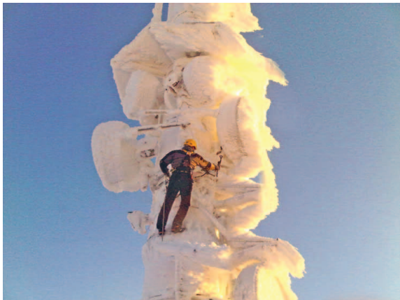
Durant l'hiver, le givre recouvre entièrement les installations qui se transforment alors en sculptures de glace.
