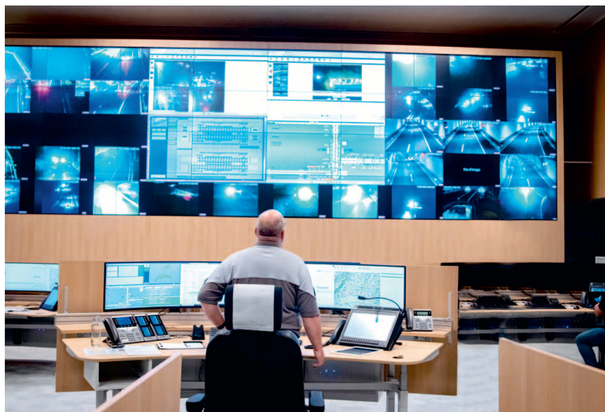
Les opérateurs trafic disposent d'un mur d'écrans qui leur permet de constater en temps réel d'éventuels problèmes survenant sur les autoroutes du canton.
