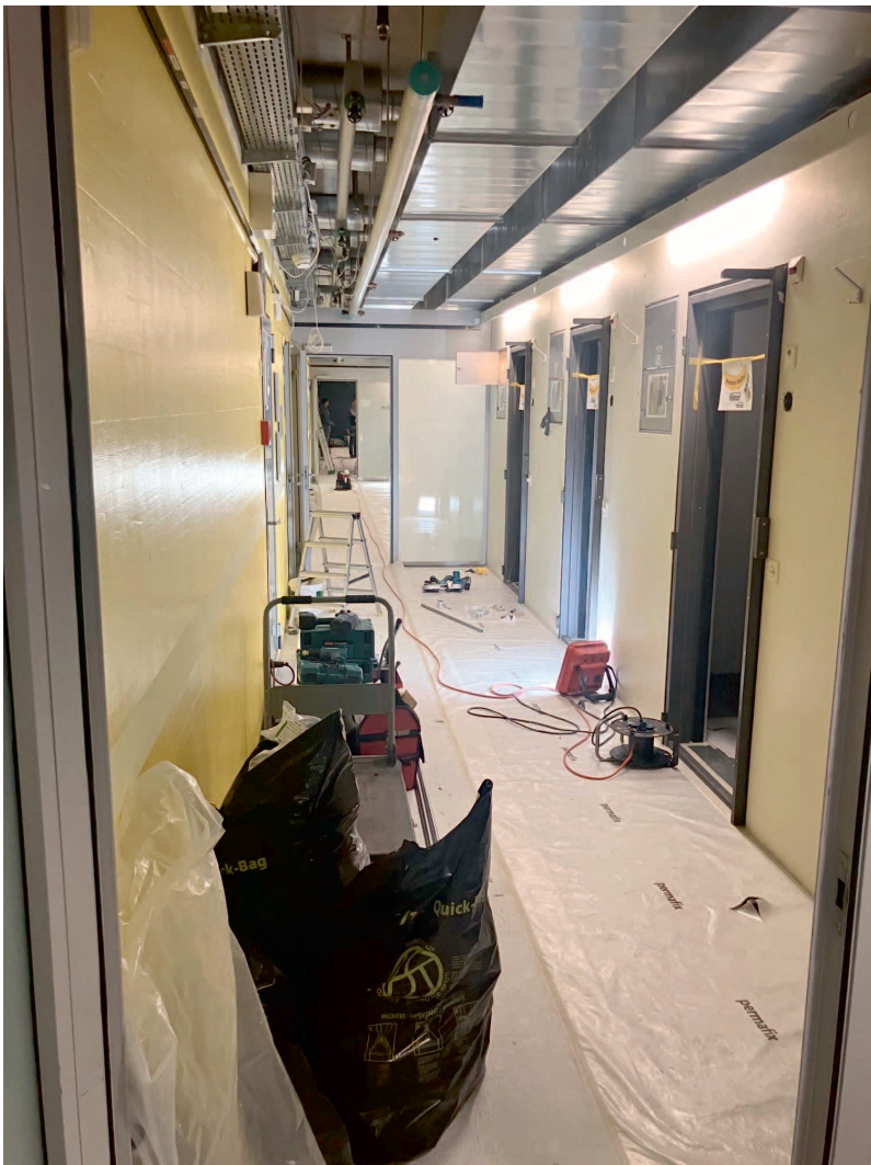
Les couloirs ont subi d'importants travaux de peinture.
