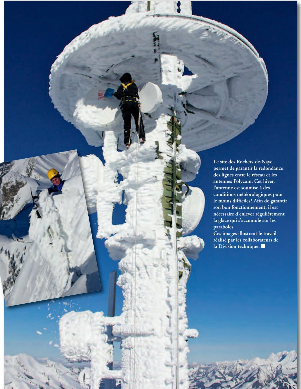
Le site des Rochers-de-Naye permet de garantir la redondance des lignes entre le réseau et les antennes Polycom. Cet hiver, l'antenne est soumise à des conditions météorologiques pour le moins difficiles! Afin de garantir son bon fonctionnement, il est nécessaire d'enlever régulièrement la glace qui s'accumule sur les paraboles. Ces images illustrent le travail réalisé par les collaborateurs de la Division technique. ■
