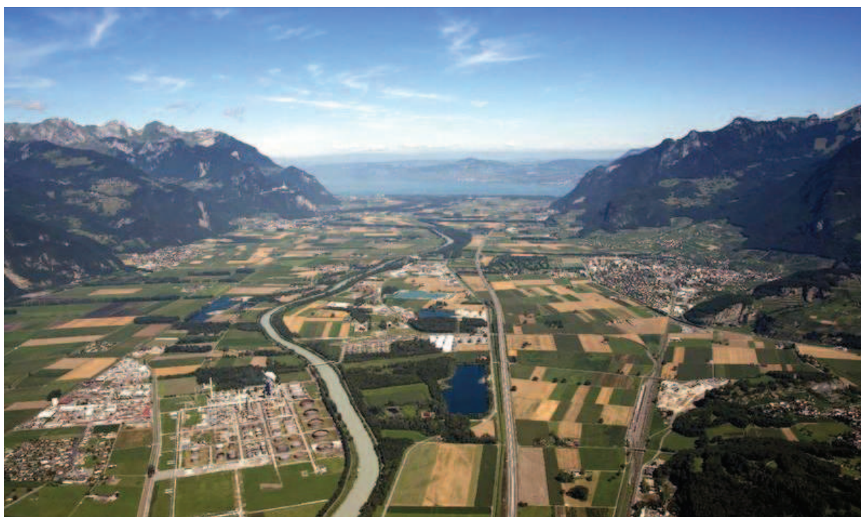
Les travaux de la 3 e correction du Rhône sont prévus sur une trentaine d'années.
