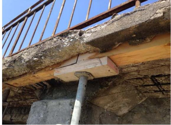
*Étayage d'urgence et dégâts à l'estacade*
