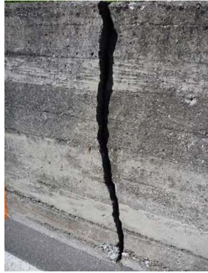
*Mur 107, fracture du béton*
