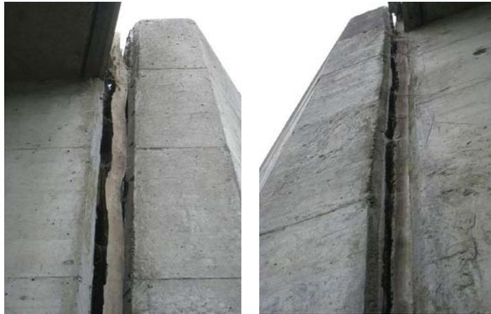
*Mur d'aile gauche se détachant du tablier    Idem sur mur côté droite*
