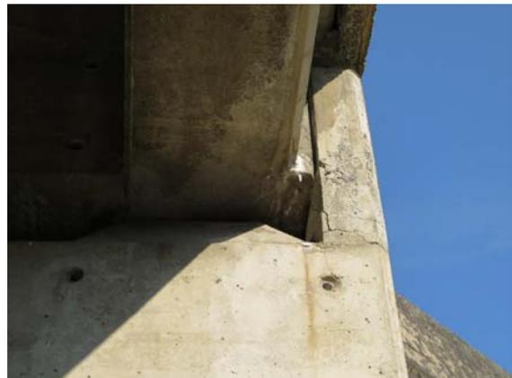
*Mur d'aile fissuré et déplacé, n'assurant plus la stabilité latérale*
