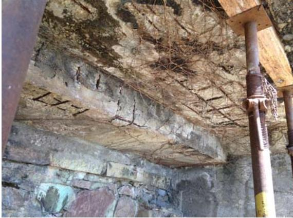
*Étayage d'urgence et dégâts à l'estacade*
