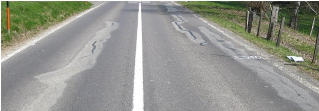
*Fissures et affaissement bord de chaussée droit*
