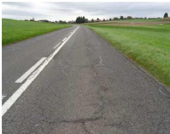
Figure 3 : Fissures dans le revêtement (voie direction Bottens)
