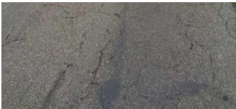
Figure 4 : Fissures dans le revêtement (voie direction Cugy)
