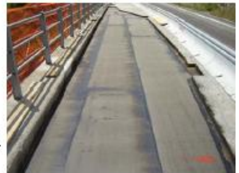
Photo 4 : Étanchéité du tablier
