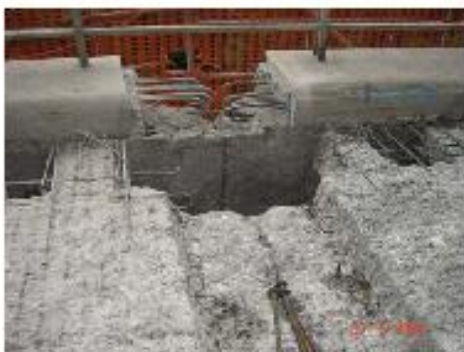
Photo 3 : Clavage (blocage) d'un joint de dilatation
