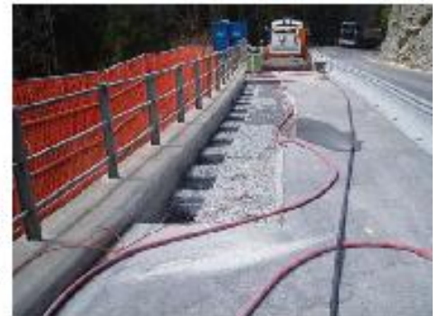
Photo 2 : Réservations pour bétonnage du sommier
