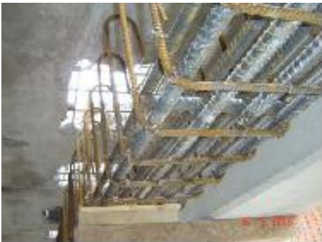
Photo 1 : Nouveau sommier de renforcement - armatures
