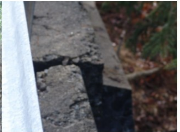
Décalage en plan des bordures indiquant un mouvement significatif du mur
