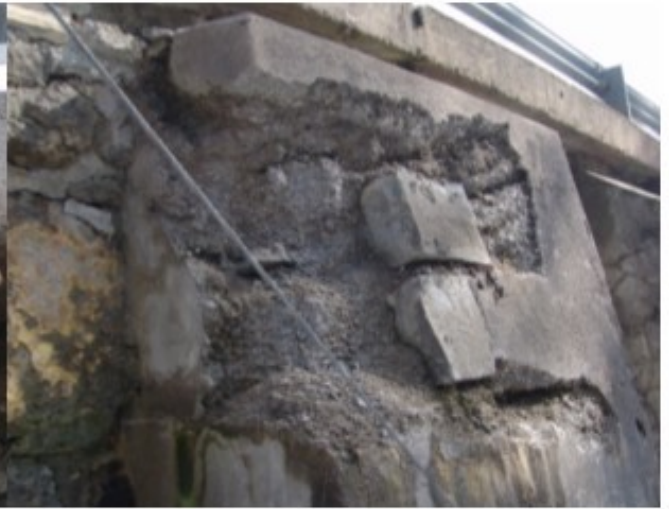
Dégâts aux contreforts, éclatements, pertes de matière importantes
