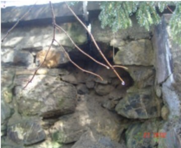
Pertes de moellons, lessivage et coulures, pertes de matériaux sous la chaussée
