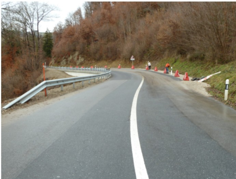
Image 3 : 20 décembre 2013 : mur terminé, chaussée réfectionnée
