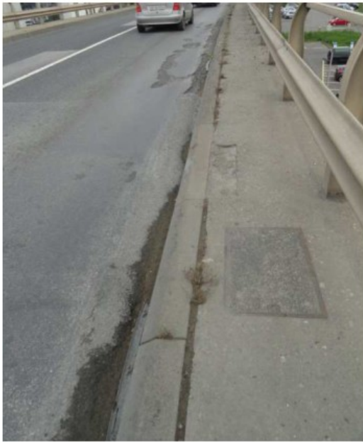
Vue du tablier existant – dégâts sur le revêtement et joint de chaussée
