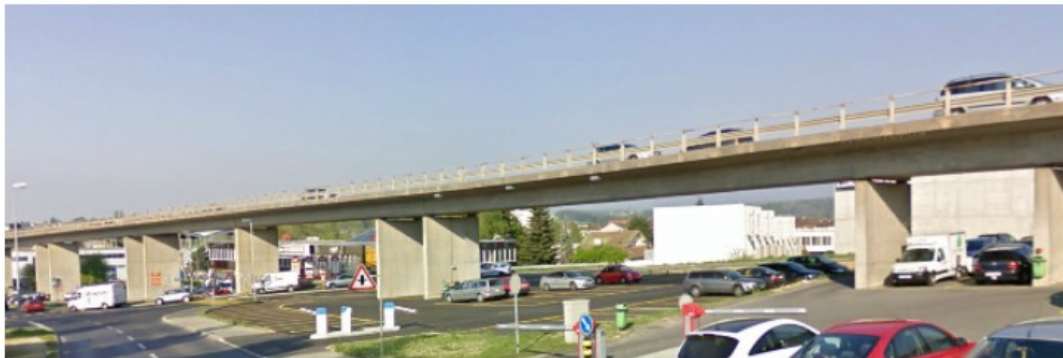
Vue générale du viaduc de Cudrex
