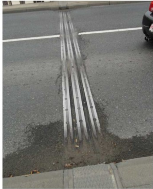
Vue du tablier existant – dégâts sur le revêtement et joint de chaussée
