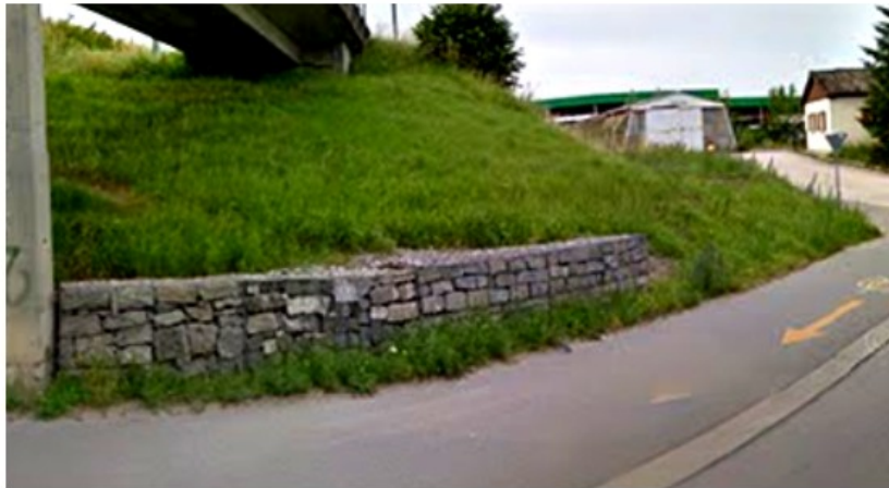
Mur en gabions existant – au-dessous du viaduc CFF
