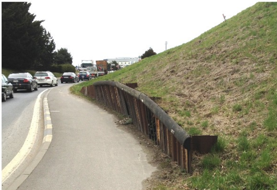
Vue générale de l'ouvrage de soutènement à remplacer
