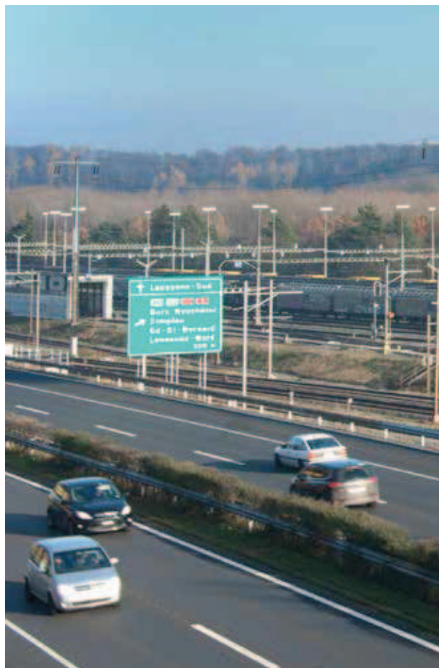
L'autoroute Lausanne-Genève, empruntée par près de 100 000 véhicules par jour, sera modernisée dans le cadre du programme d'élimination des goulots d'étranglement et du nouveau fonds routier.
