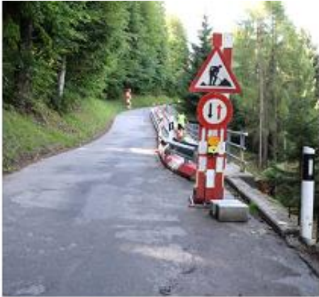
Photo 5 : Déviation de trafic
