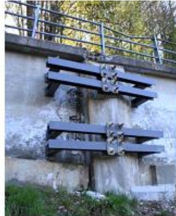
Photo 6 : Renforcement provisoire vers le centre de l'ouvrage y c remplissage des vides sous le mur
