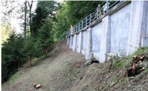
Photo 1: Vue du mur côté Le Sépey
