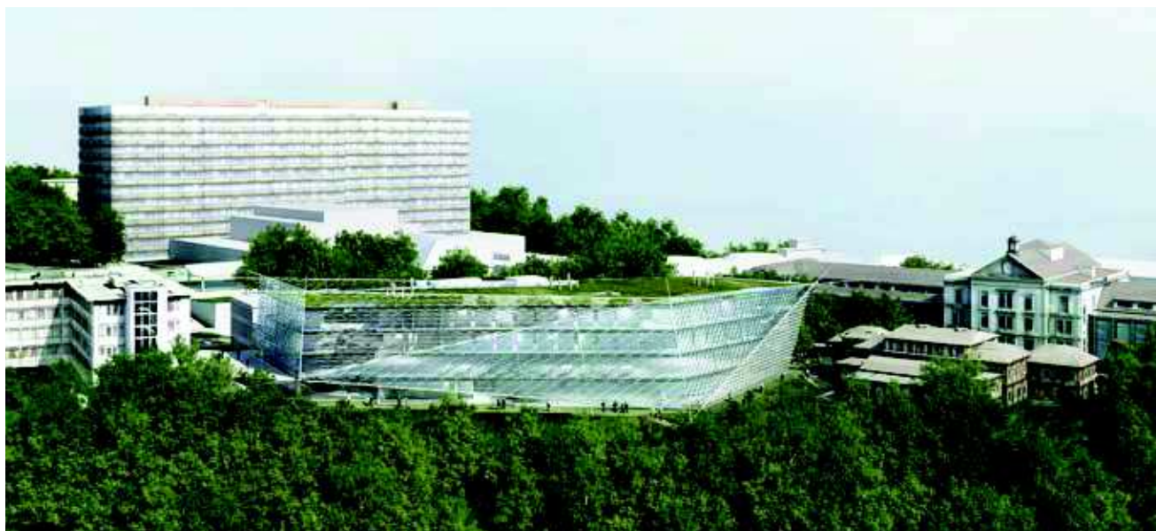
La construction du bâtiment AGORA-Centre du Cancer qui accueillera près de 300 scientifiques et médecins a démarré en 2016 sur le site du CHUV. Ce projet est le fruit d'un partenariat entre la Fondation ISREC, le CHUV, l'Université de Lausanne, l'EPFL et le Ludwig Institute for Cancer Research, auquel se sont associés l'Université de Genève et les HUG depuis l'année passée.
