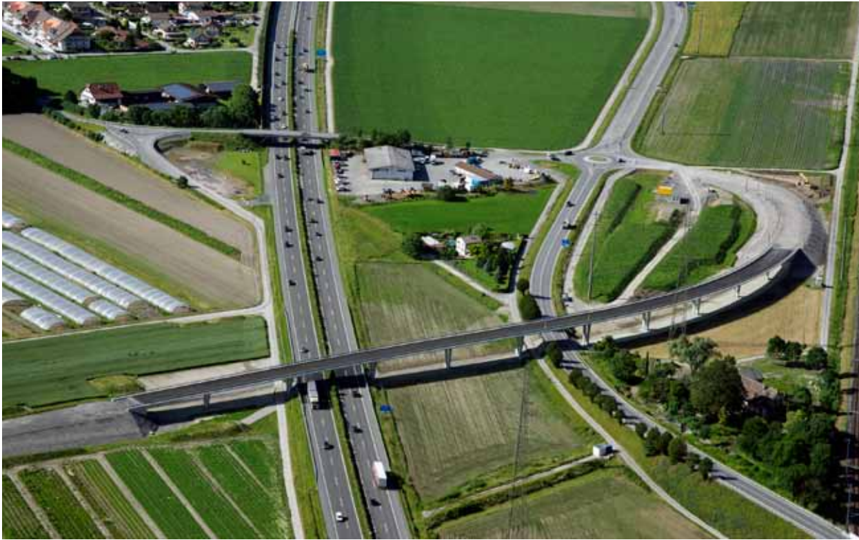
Le viaduc sur l'autoroute A9, à l'instar des 3 autres ouvrages de la H144, a fait l'objet d'un concours visant à la meilleure intégration possible dans le paysage. Le chantier a été conduit dans le respect du développement durable.
