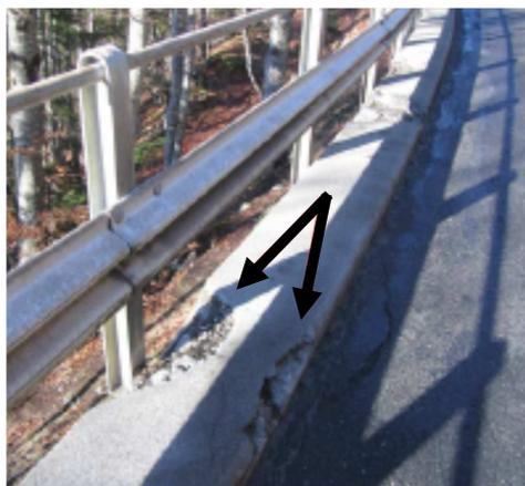
Figure 5 : Exemple de dégradation de bordures
