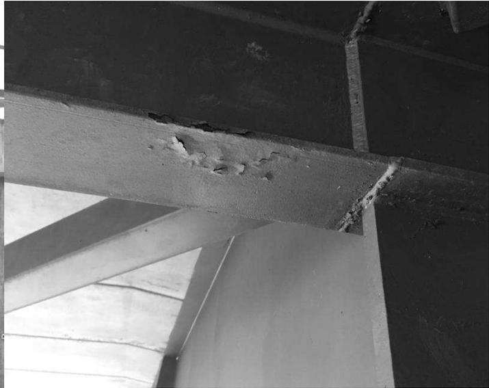
Photo 11 : détails des dégâts corrosion
