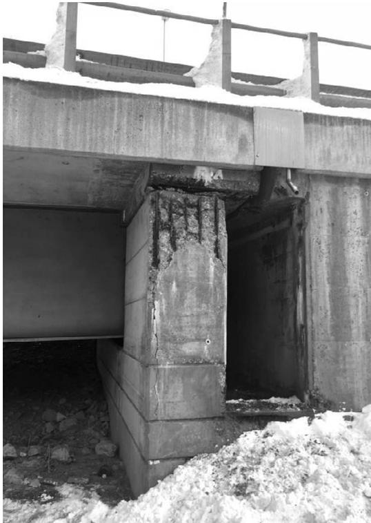
Photo 10 : détails des dégâts culée
