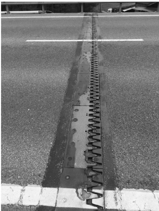
*Photo 14 : Joint de chaussée dégradé*
