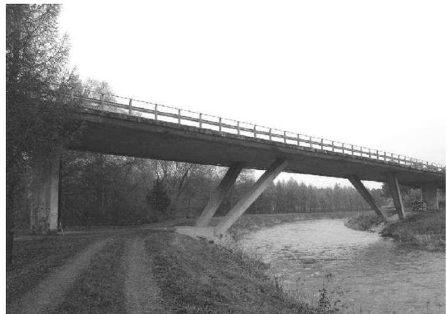
*Photo15 : vue des piles avec chambres enterrées*
