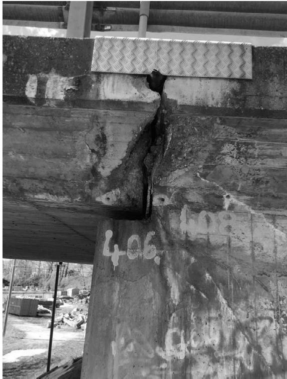
Photo 8 : détails des dégâts culée
