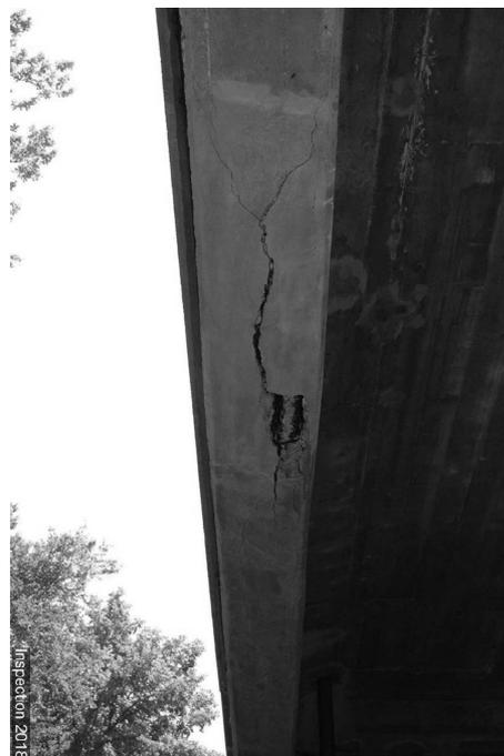
Photo 7 : fissure avec corrosion
