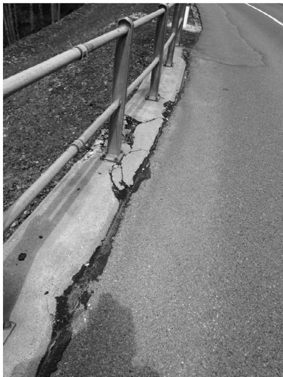
*Photo 4 : longrines fortement dégradées sur mur en maçonnerie*
