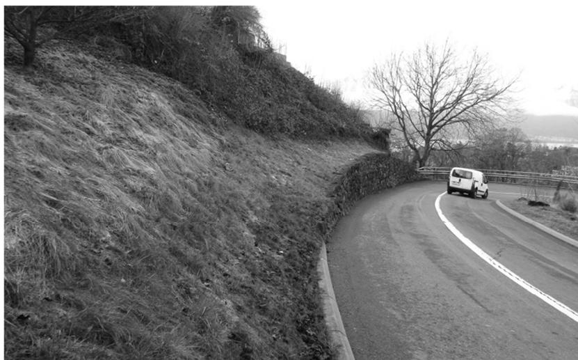
Figure 16 : Mur existant déformé et dégradé, vue depuis l'amont
