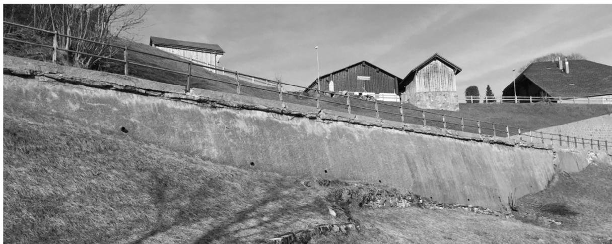
Figure 10 : Mur existant, partie centrale très dégradée au couronnement
