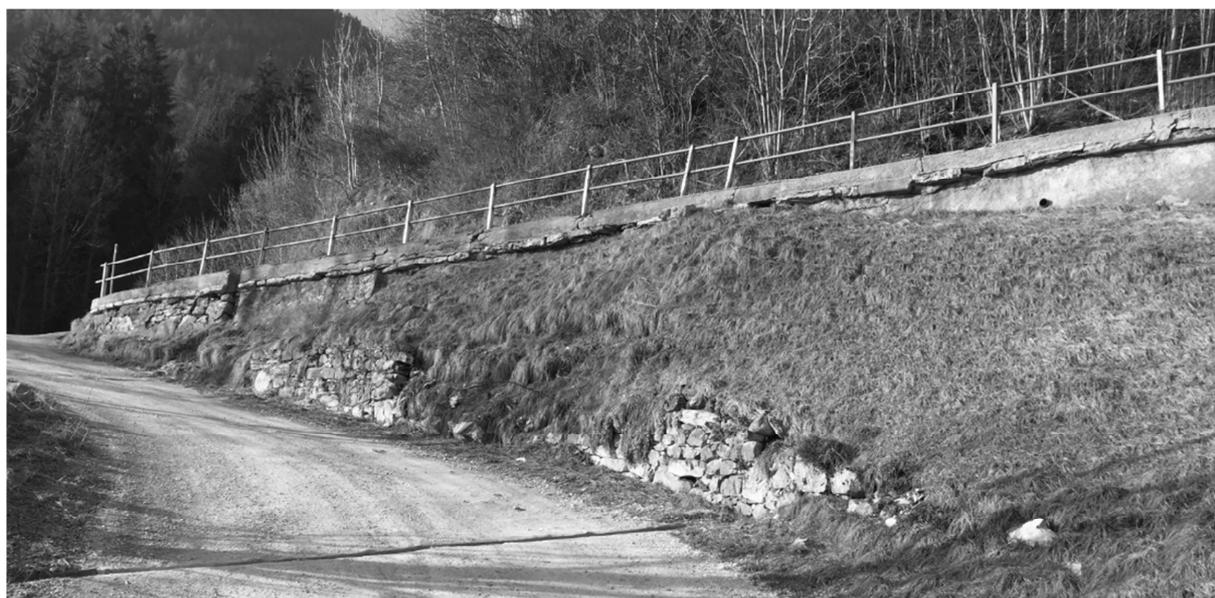
Figure 9 : Mur existant, partie ouest très dégradée
