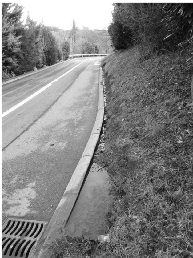
Figure 18 : Talus amont instable avec écoulement actuel des eaux
