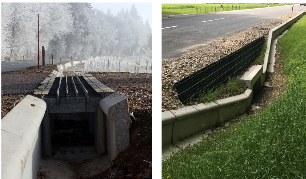
Figure 4 : illustration du passage à batracien
