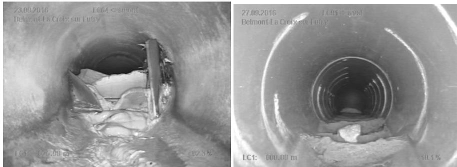
Figures 3 et 4 : Canalisations obstruées par le calcaire
