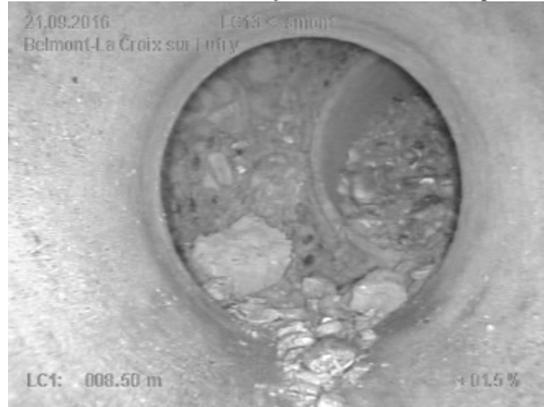
Figure 6 : Effets des glissements sur les canalisations.
