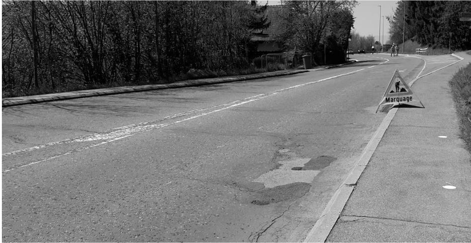
Figure 2 : Fissures et décollement du revêtement
