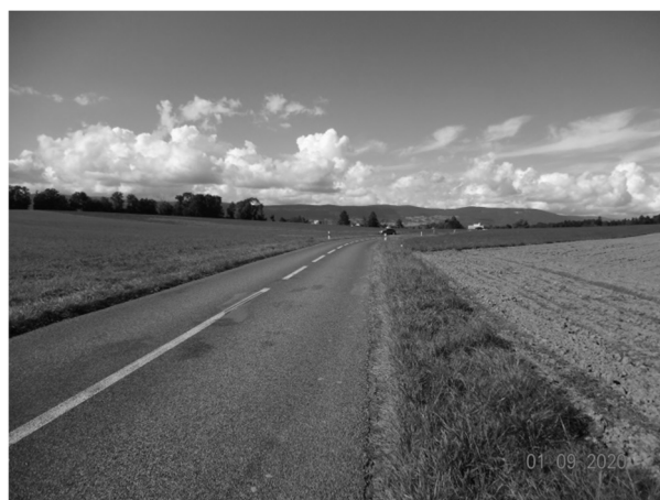
Photo 2 – RC 425, vue direction Yverdon-les-Bains, état dégradé de la chaussée et des bords
