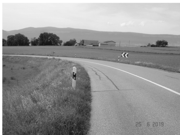
Photo 1 – RC 422, vue direction Yverdon-les-Bains, état dégradé de la chaussée avec affaissement de bord
