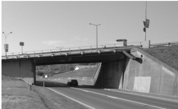
Photo 1 : Pont routier des Sorbiers sur le RC 601
