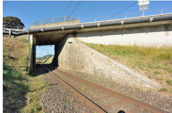
Photo 2 : Pont CFF des Sorbiers
