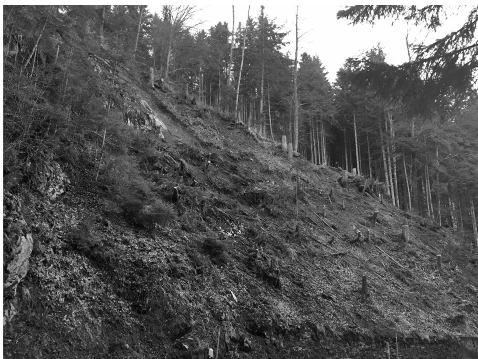
Figure 19 :RC 716 Versant après l'évènement de 2018 et les travaux forestiers
