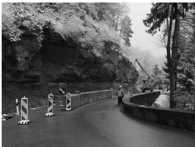
Figure 12 : RC 543 travaux d'urgence suite à l'évènement
