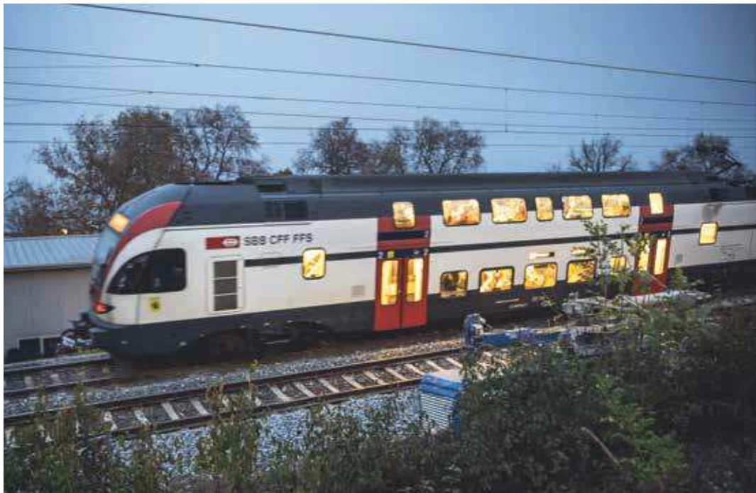
Sur ce secteur, à la hauteur de Tolochenaz, un affaissement des voies a entraîné une interruption de trafic de trois jours. Cet événement démontre l'importance de réaliser une nouvelle ligne par étape, ce que demandent les gouvernements vaudois et genevois.
