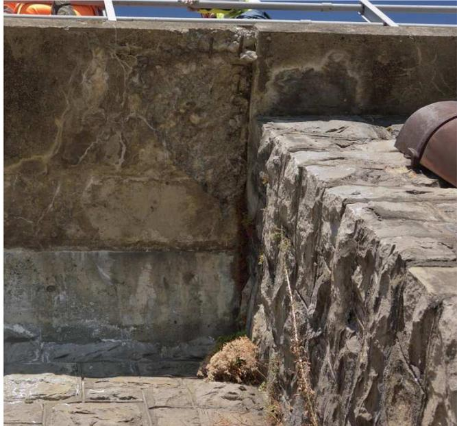
Fig. 9 et 10 : dégradations sous les estacades
