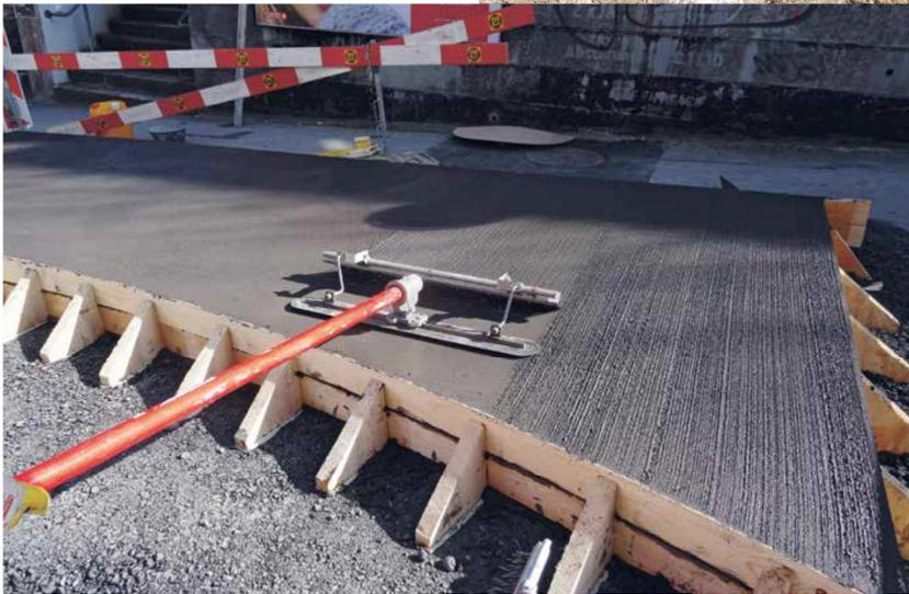
*Fig. 23: Exemple de finition au balai*
