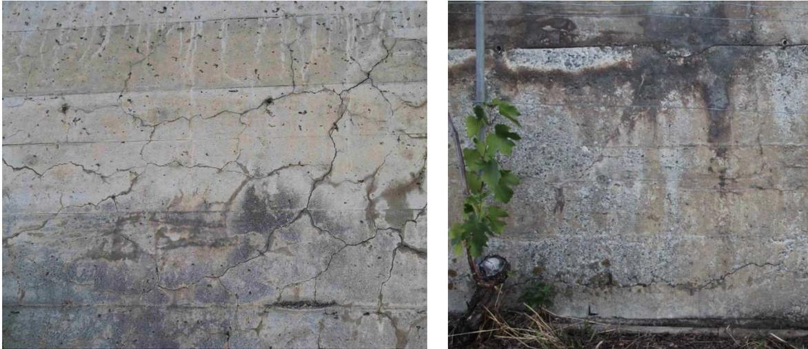
*Fig. 15 : dégradations des murs en béton (RAG)*
