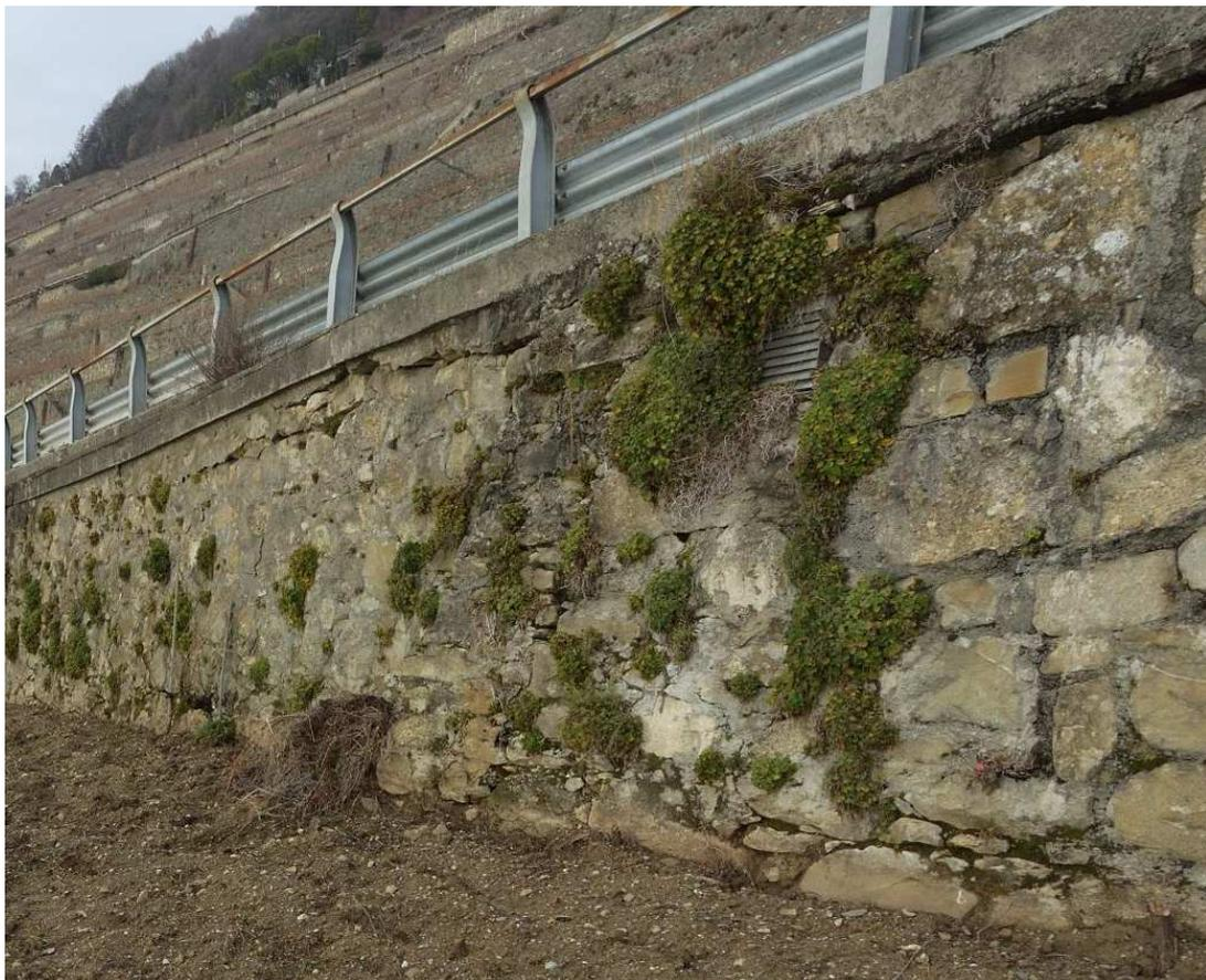
*Fig. 16 : dégradations des murs en maçonnerie*
