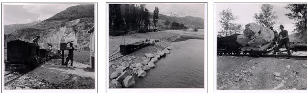
Figure 4 : Extraction, transport et mise en place de blocs pour la deuxième correction
