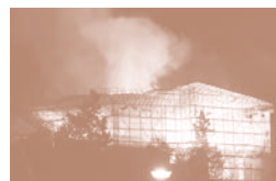
d Incendie du 13 mai 2002
