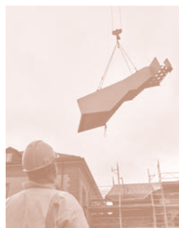
e Installation de l'escalier pendant les travaux
