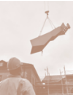
e Installation de l'escalier pendant les travaux
