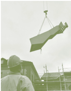
e Installation de l'escalier pendant les travaux
