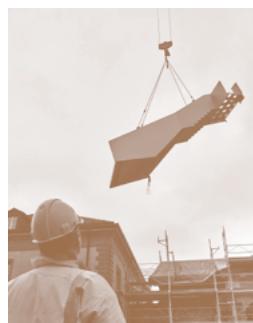
e Installation de l'escalier pendant les travaux
