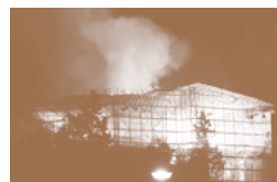
d Incendie du 13 mai 2002
