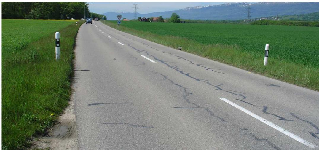
Figure 3 : Fissures dans le revêtement (direction giratoire de la Placette)
