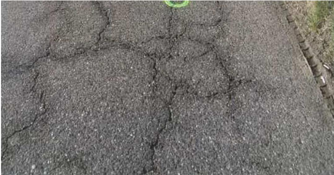
*Figure 5 : Fissures dans le revêtement (voie direction giratoire de la Placette)*
