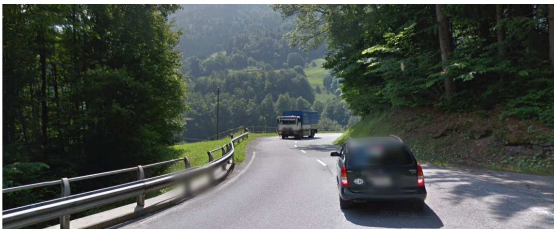
Fig. 4 Tracé sinueux et manquant de visibilité
